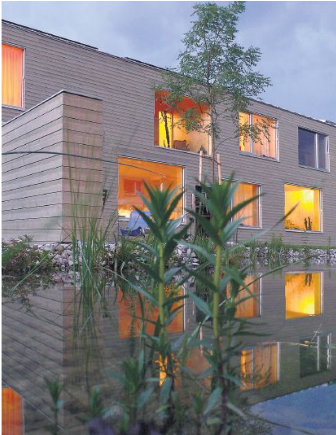
Holz prägt das dreigeschossige Gebäude auf der einst verwilderten Parzelle
